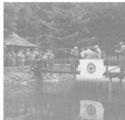
Nach der Renovierung 1959
